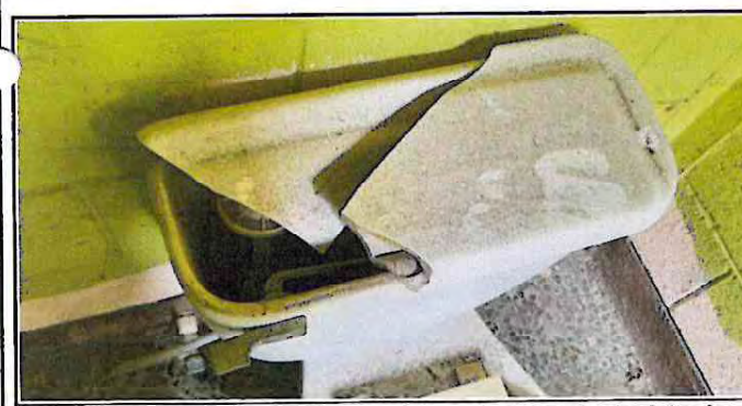
Foto 5: Inodoro en baño de niños con daño en tapadera del depósito de agua. Fuera de funciones.
